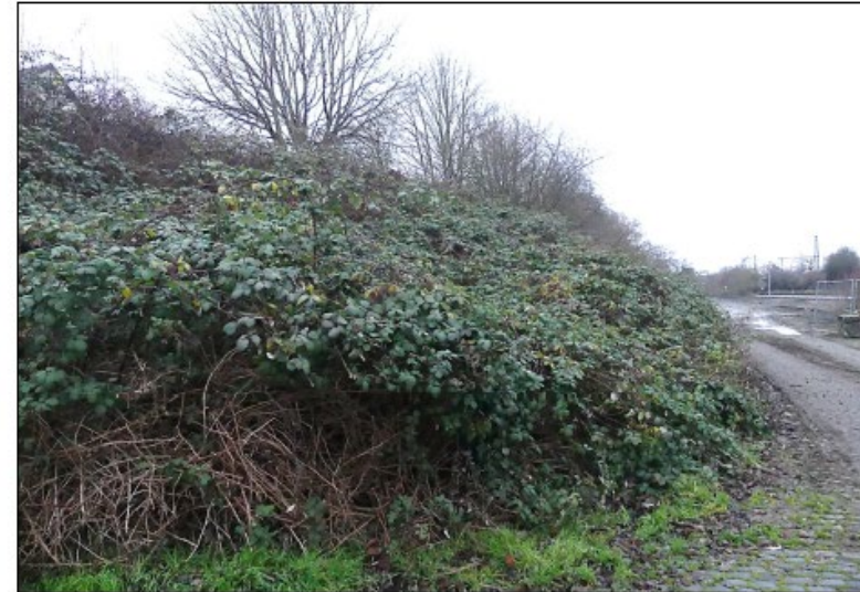
Abbildung 5: Die mit Brombeeren bewachsene Böschung wird als Lebensraum im Zuge der Baumaßnahme weitgehend verloren gehen (Foto: IBU, 17.12.2021).
